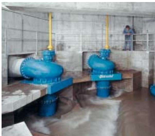
*Abwasserhebeanlage mit vertikaler Montage und PREROSTAL® Mengenreguliersystem*
